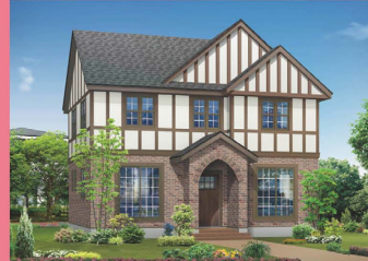
Half Timber (ハーフ・ティンバー) 急勾配の切妻屋根にダークな色調の瓦葺、1階はレンガや石造り、2階は木造が主体となる建築様式。柱、梁、斜材(筋違)、間柱、窓台等の組組を、あえて見せるデザインが特徴で、クラシカルな味わいが魅力の外観です。
